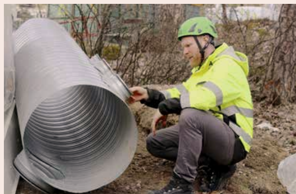
INFÖR MONTERINGEN. Projektledaren Björn Pettersson inspekterar ett ventilationsrör.
