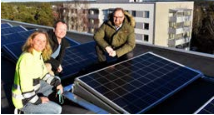
Rose-Marie Hedh från WSP, Torgny Rydberg från Brf Fogdetorp och Stefan Forsberg från SmartFront vid solcellspanelerna på taket.
